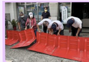
協助社福機構架設移動式防水擋板
